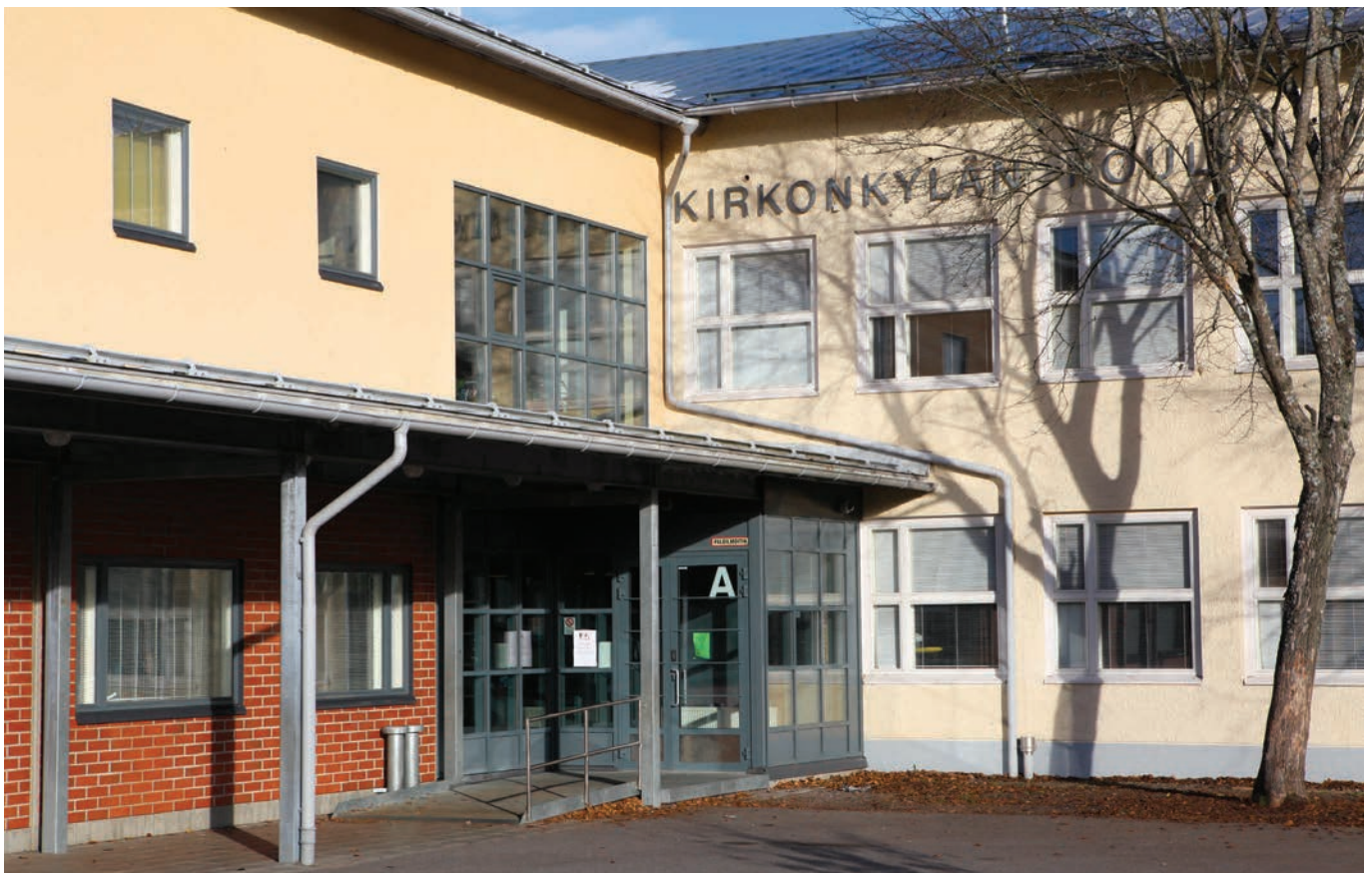
Yllä: kuva 48, 2007 laajennusosan liittyminen vanhaan rakennukseen, nykyinen pääsisäänkäynti
