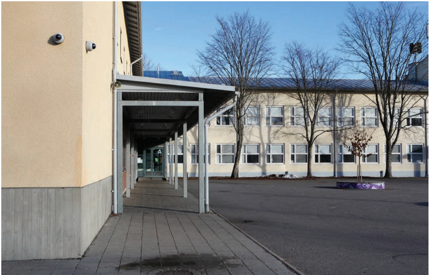
Yllä: kuva 47, 2007 laajennusosan sisäänkäyntikatos
