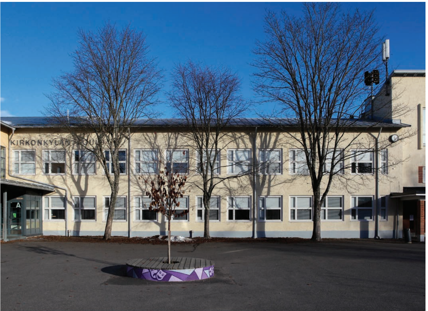
Yllä: kuva 9. Kirkonkylän koulun eteläjulkisivu, luokkahuonesiipi
