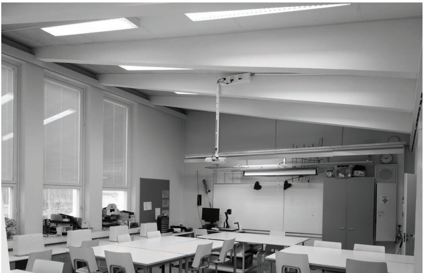
Yllä: kuva 28. Ullakkokerroksen luokkahuone, alakattopalkit
