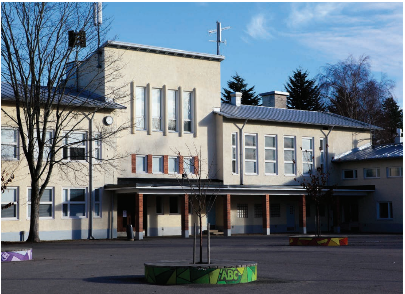
Yllä: kuva 10. Kirkonkylän koulun eteläjulkisivu, alkuperäinen pääsisäänkäynti, voimistelusalin (nyk. monitoimitila) korkeat ikkunat
